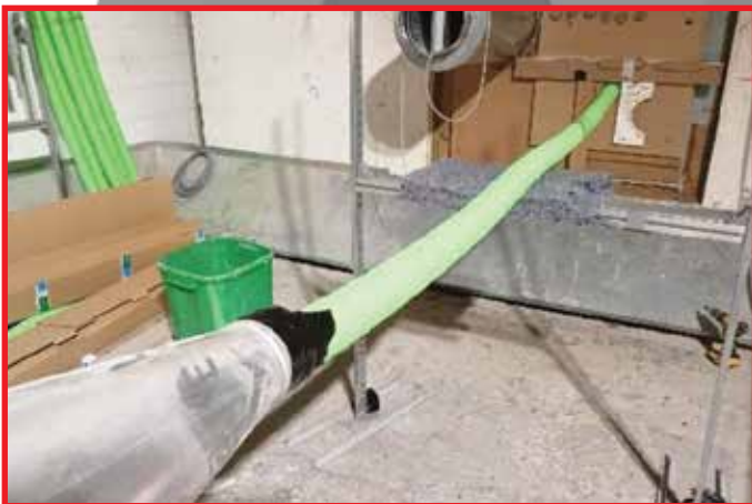
Imagen del ensayo de impulsión directa sin caja de distribución
